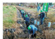
●水路の泥上げ
