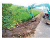
●農道法面の初期補修
