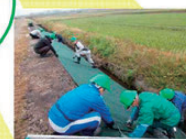
●水路法面保護
