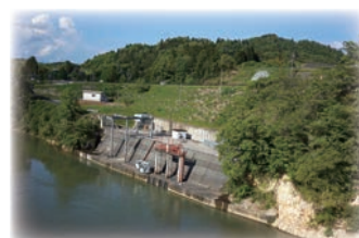
最上川頭首工 (朝日町大字四ノ沢地内)
