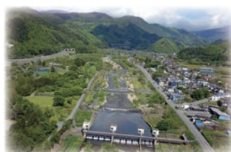
馬見ヶ崎川合口頭首工 (山形市大字妙見寺地内)
