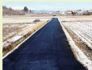
【農道舗装（長寿命化）】
