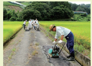
【農道補修作業】
